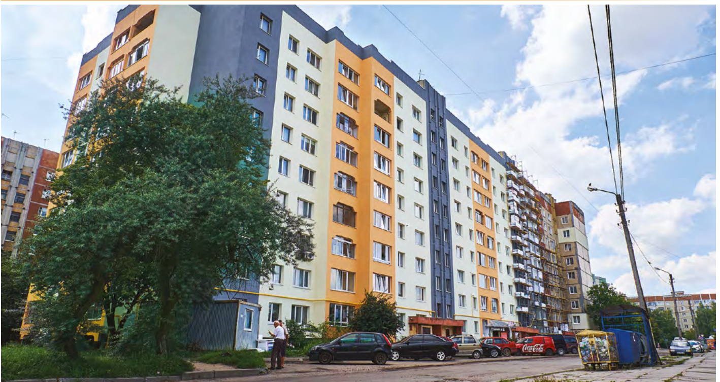
Зображення №14: Утеплення фасаду будинку на вул. Гната Хоткевича 30А (фото - Lviv.com)
