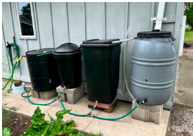
Система збору дощової води виготовлена з декількох ємностей (фото з мережі)
